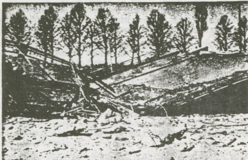
De vernielde brug over kanaal Almelo-Nordhorn in straat Denekamp - grens.
