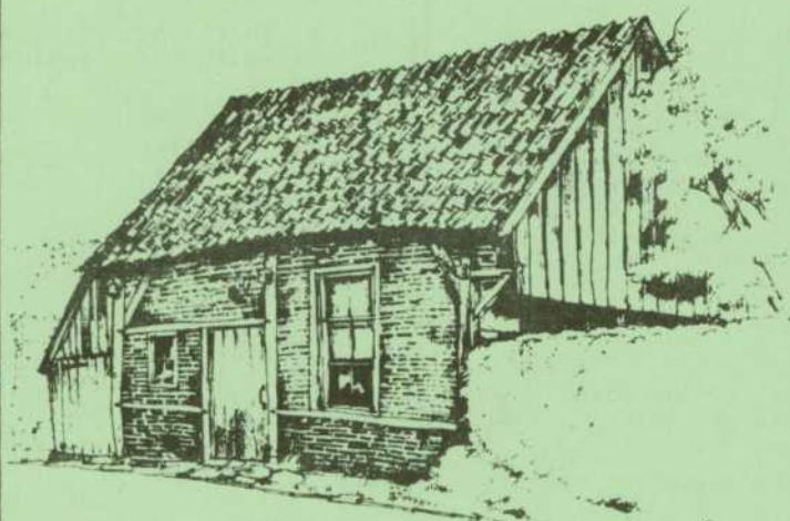
Klöpfeshoes aan de Wilhelminastraat te Denekamp. Vakwerkskelet, oorspronkelijk leemvullingen. Onder het zadeldakje bevonden zich een woonkeu- ken en twee kleine vertrekjes. Het strodak werd vervangen door pannen. Gesloopt omstreeks 1950.
